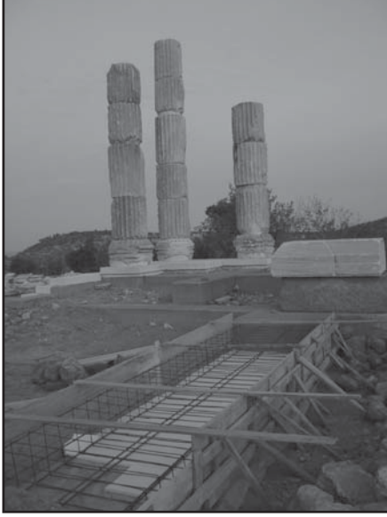
Resim 9: Tapınak pronaos t f temellerin restorasyonu
